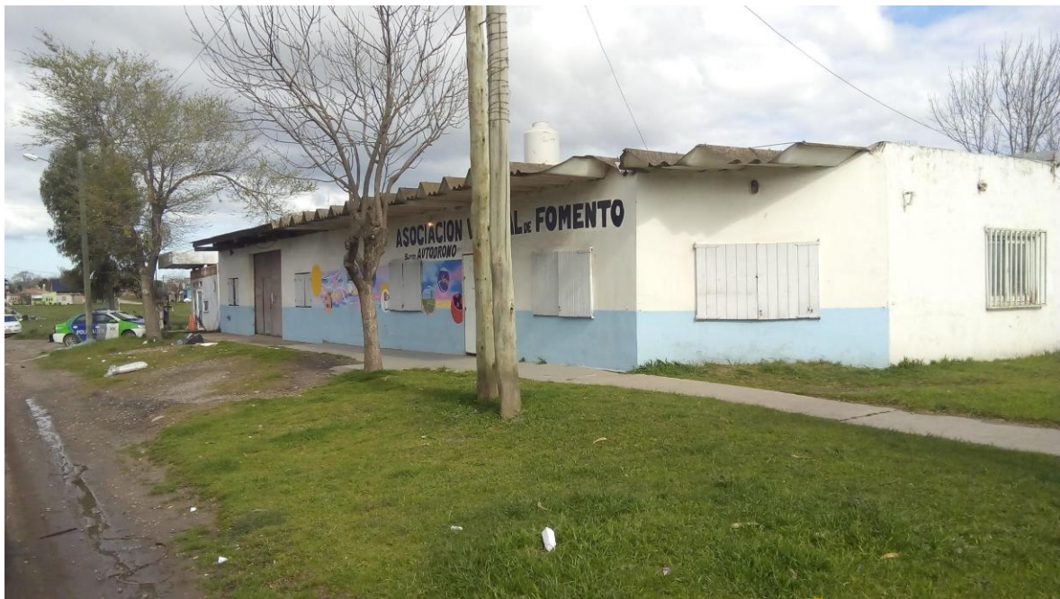
Sector frente a la Asoc. Vecinal de Fomento sobre calle Rosales.
